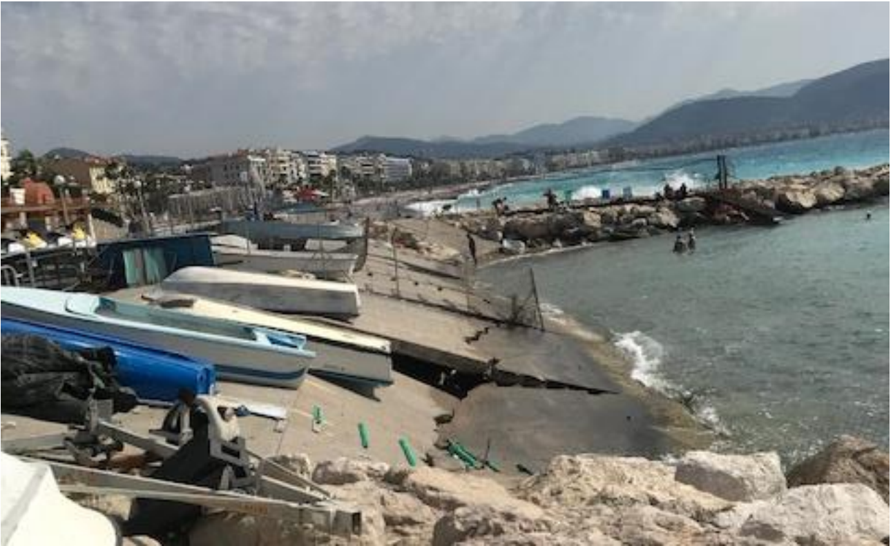
Photo 1 : Dalle béton fracturée
