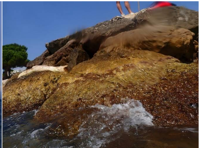
Photo 8 : Roches médiolittorales au niveau du musoir de l'épi Ouest
